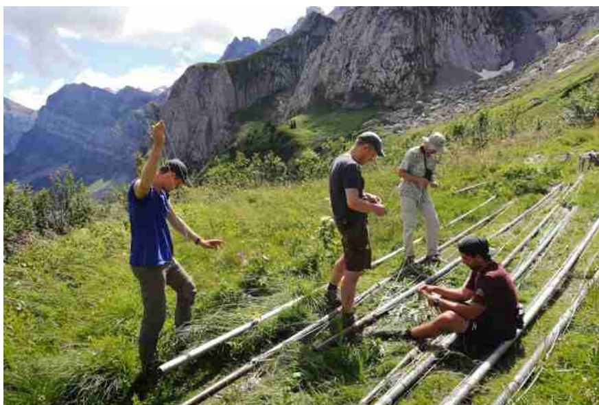
Fig. 5. Livio Rey, Mike Schaad, Simon Birrer et Simon Hohl (de gauche à droite) lors du montage des hauts-filets le 25 juillet. – The team working on setting up the high nets on July 25 th .
